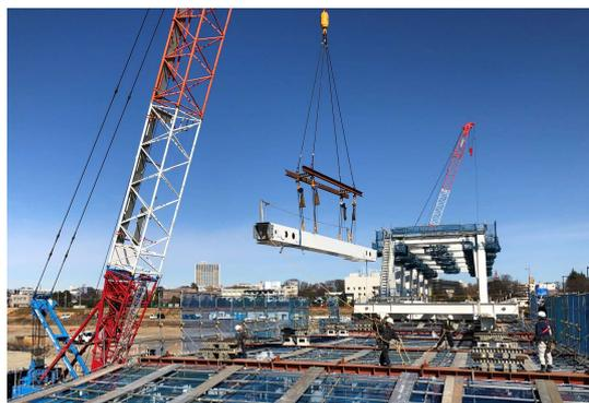
写真-1 下弦材地組ブロック架設状況
