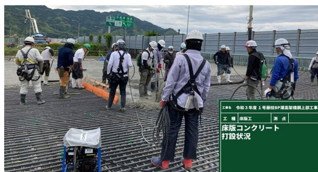
写真-5 床版コンクリート打ち込み状況
