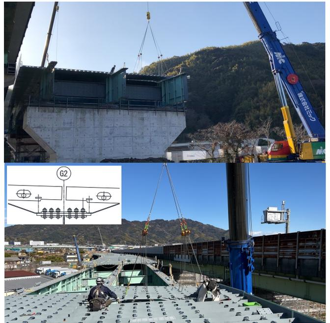
写真-3 合成床版架設状況
