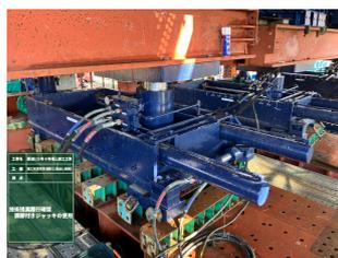
写真-7 横方向調整装置
