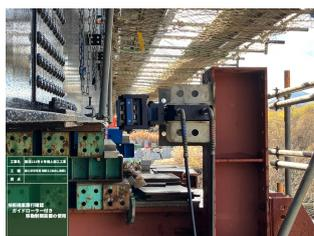
写真-6 移動制限装置
