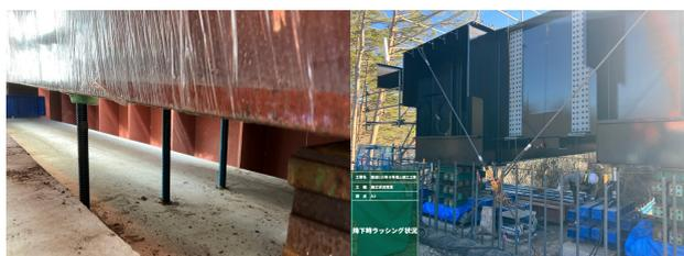
写真-2 基礎梁固定Rアンカー・ラッシング状況
