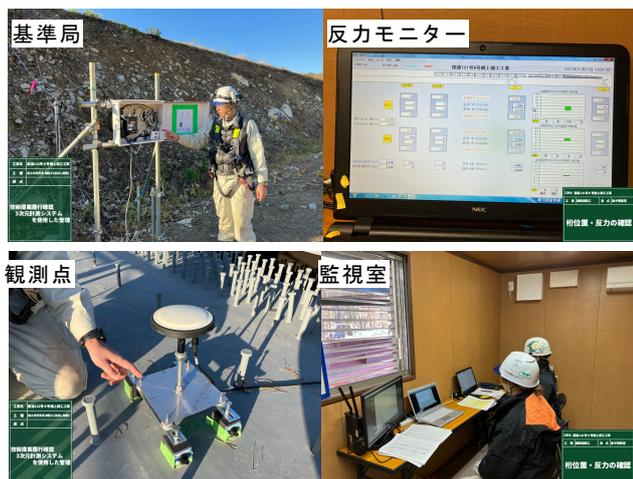
写真-8 桁位置・反力の監視システム
