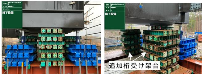
写真-1 桁受け架台
