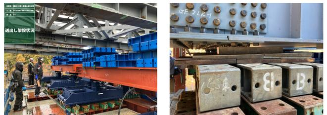
写真-3 送出し桁受設備・テーパライナー
