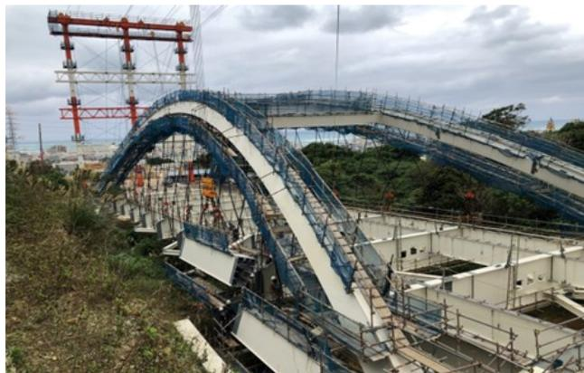
写真-10 補剛桁架設状況写真
