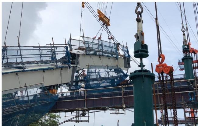
写真-8 アーチリブ架設状況写真（仕口合わせ状況）
