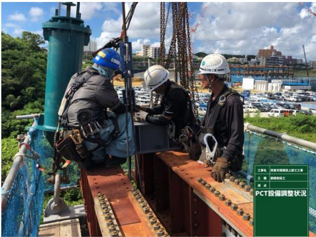
写真-6 吊索張力調整状況
