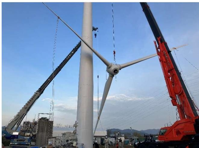
写真-10 ロータ架設作業
