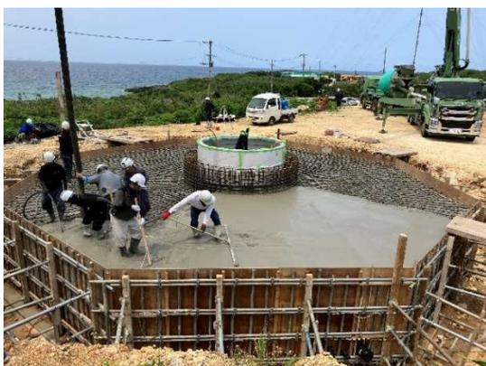
写真-1 基礎工事（コンクリート打ち込み状況）
