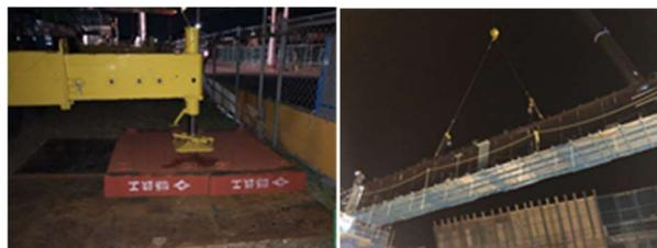
写真-3 アウトリガ養生 写真-4 吊足場
