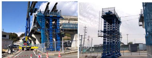
写真-1 側道上架設クレーン 写真-2 ベント転倒防止
