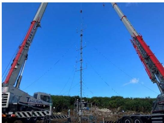
写真-1 風況観測マスト架設状況
