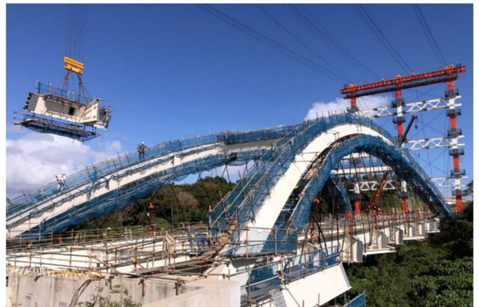
ケーブルクレーンによる架設状況
