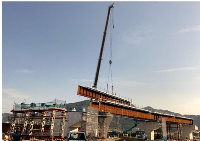
220t吊オールテレーンクレーンによる架設
