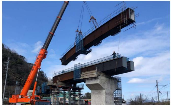
220t 吊オールテレーンクレーンによる架設
