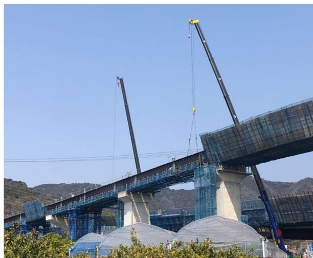
100t吊トラッククレーンによる架設
