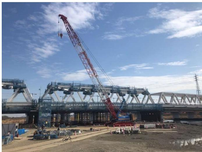
100t吊クローラクレーンによる架設
