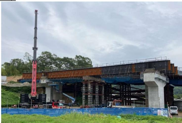
360t 吊オールテレーンクレーンによる架設
