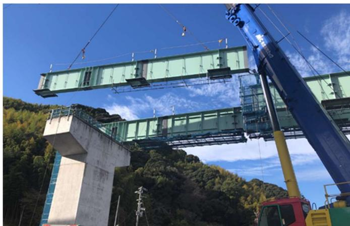
200t 吊トラッククレーンによる架設
