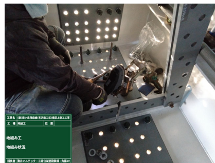
低騒音用架設機材油圧式ピン挿入機スピードセッター
