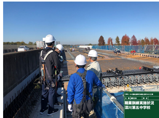
手代木橋 深川第五中学校職業訓練
