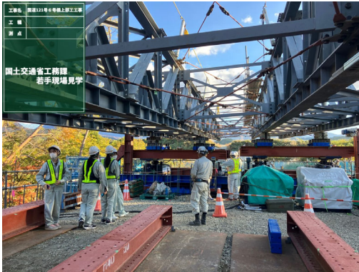
国道 121 号 6 号橋 国交省現場見学会
