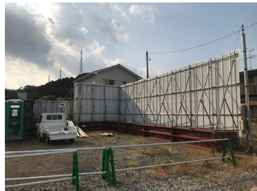
防音アフィラウォール設置
