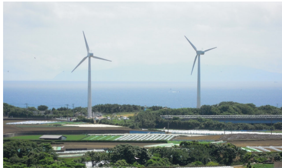
三浦宮川風力発電所
