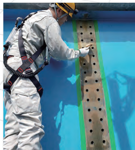
当社開発「ヒットロックK」を用いた 高力ボルト摩擦接合面処理
