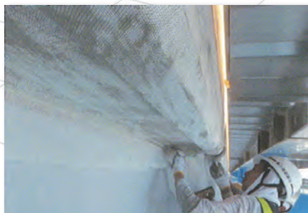
当社開発「アロンブルコート® Z-X工法」による コンクリート剥落防止工事
