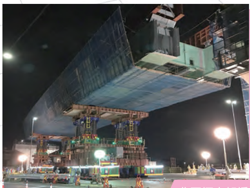
北玉垣高架橋
