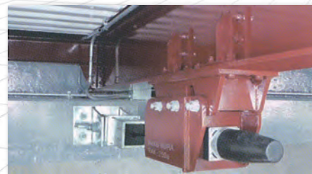
当社開発「らくらくブラケット」による 落橋防止装置の設置工事
