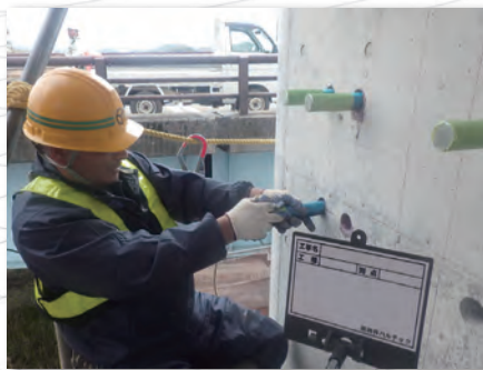
仮設備を設置するため 当社開発「Rアンカー」の施工状況
