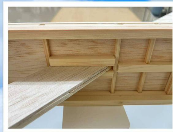
路面に開口部を設け、1体化した構造体が貫通する構造にしました。
