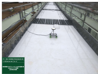
写真-5 GNSS アンテナ設置
