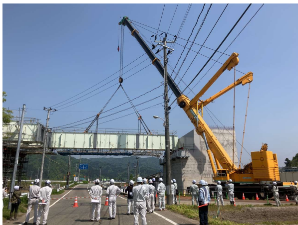
写真-11 550t吊油圧クレーンによる市道上架設
