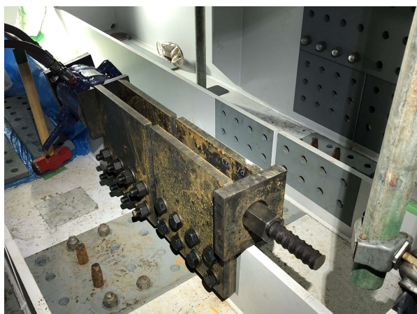
写真-12 センターホールジャッキを使用した引込み装置
