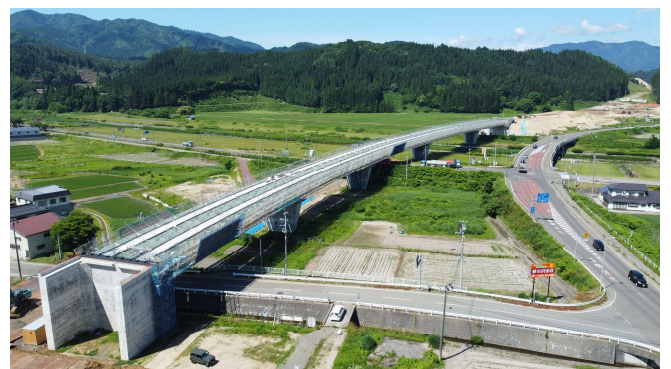
写真-14 桁架設完了
