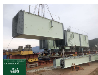
写真-3 送出し桁地組
