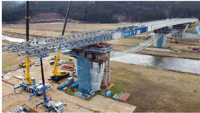
写真-4 送出し状況
