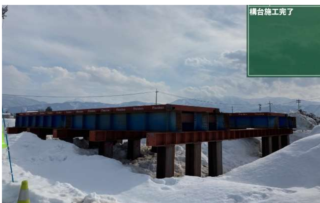
写真-1 作業構台完了
