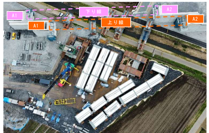
写真-2 主桁仮置状況
