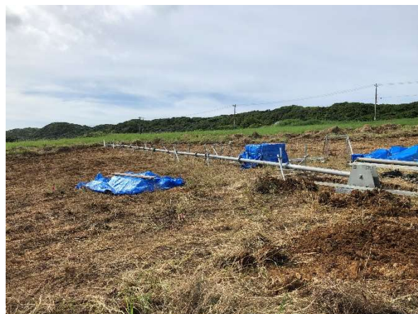
写真-1 ポール地組状況
