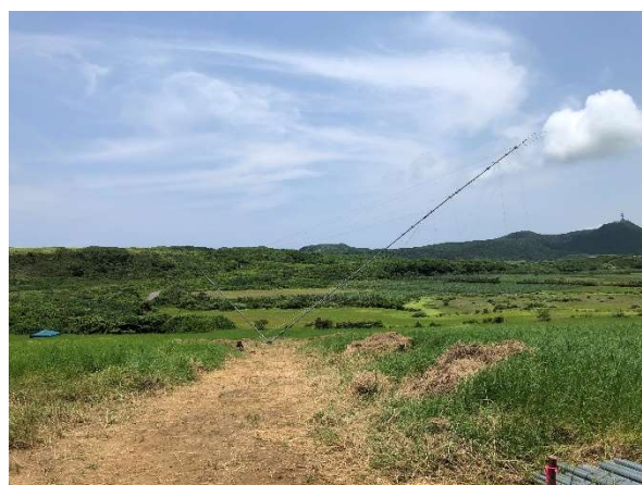
写真-3 建て起こし状況
