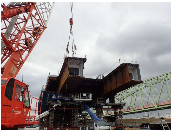
200 t吊クローラクレーンによる架設
