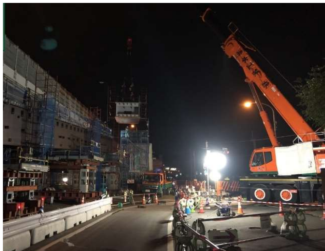
A1-P1 架設状況 (220t 吊オールテレーンクレーン)
