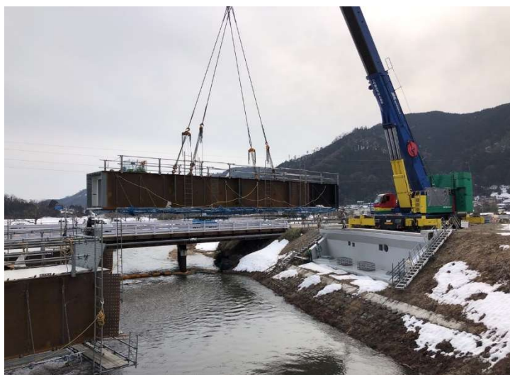
550 t吊オールテレーンクレーンによる架設
