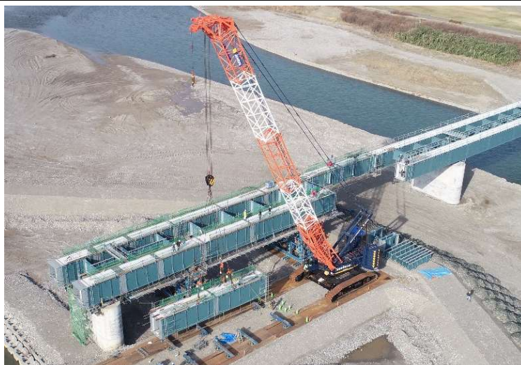
300 t吊クローラクレーンによる架設
