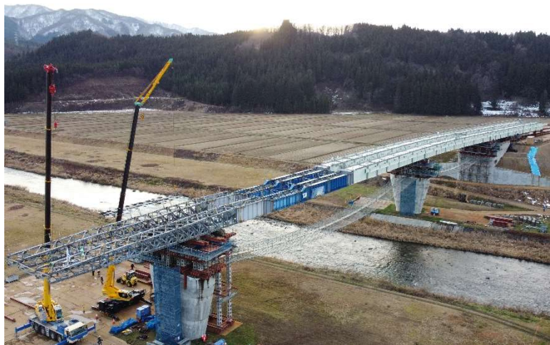
手延べ機による送出し架設（A1-P2）
