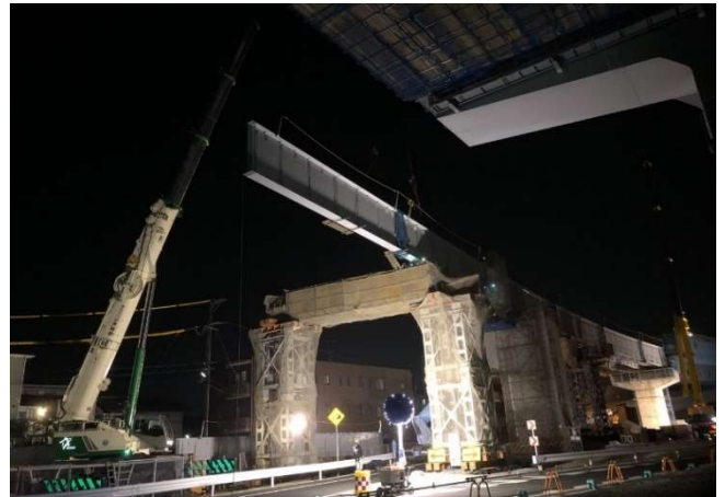
120 t吊トラッククレーンによる架設
