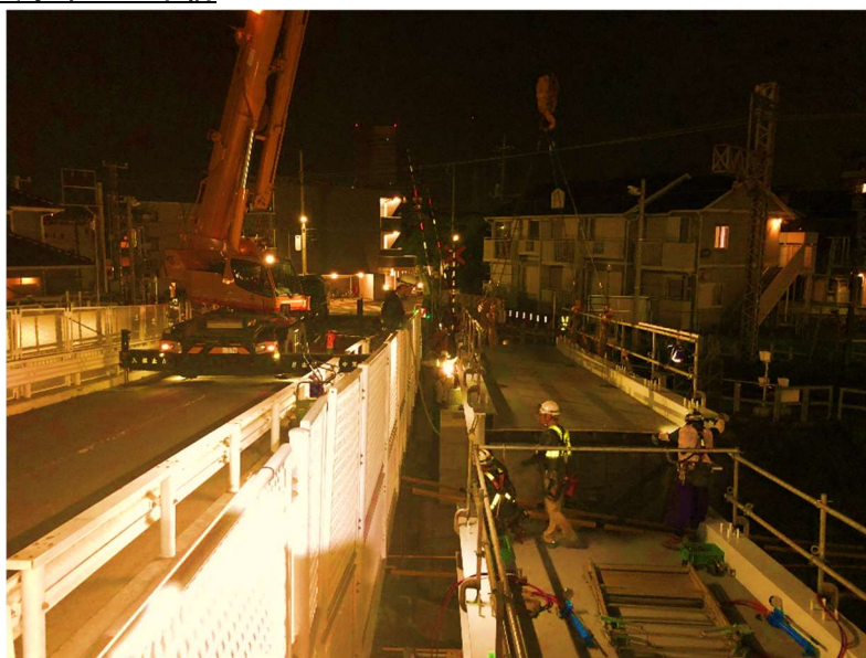
70 t吊ラフテレーンクレーンによる架設
