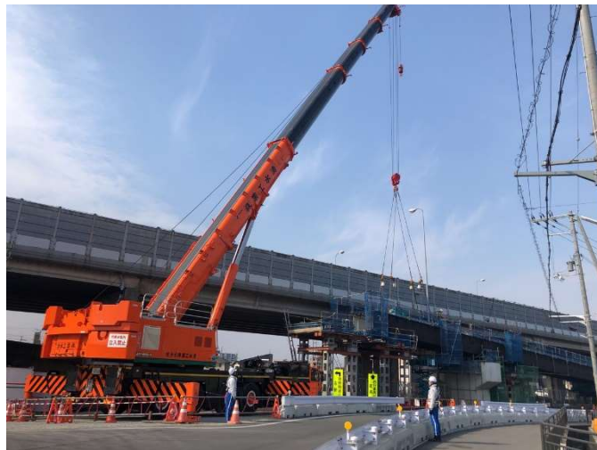
P2-A2 架設状況 (400 t 吊オールテレーンクレーン)
