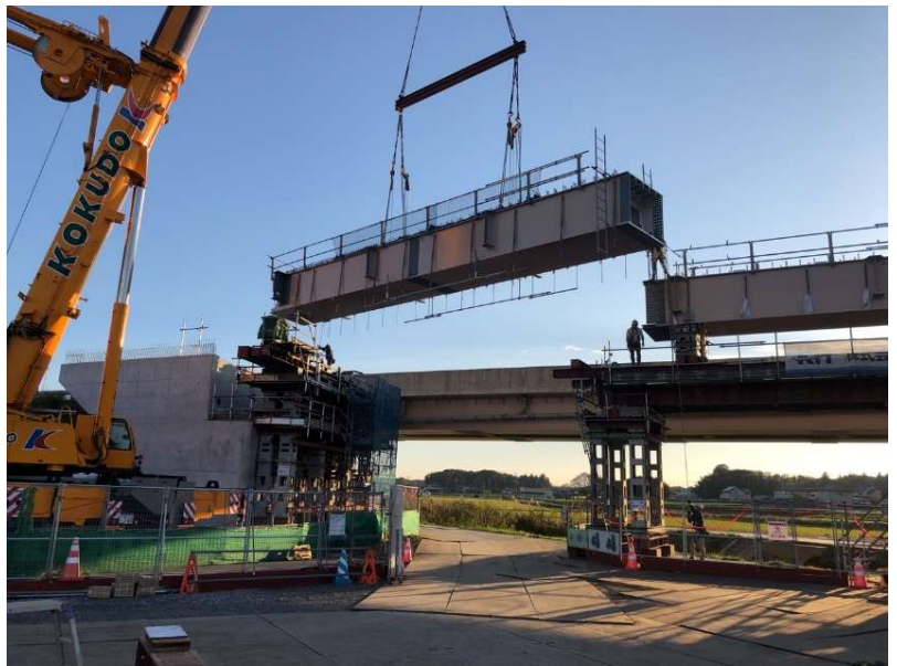
360 t吊トラッククレーンによる架設
