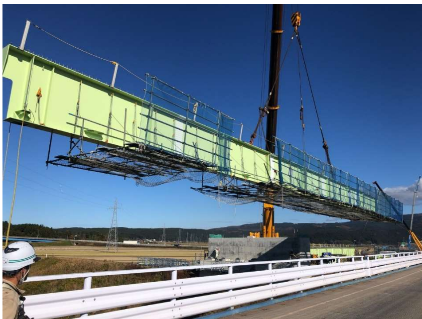
650 t吊トラッククレーンによる架設
