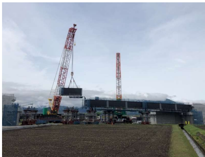
500 t吊クローラクレーンによる架設
