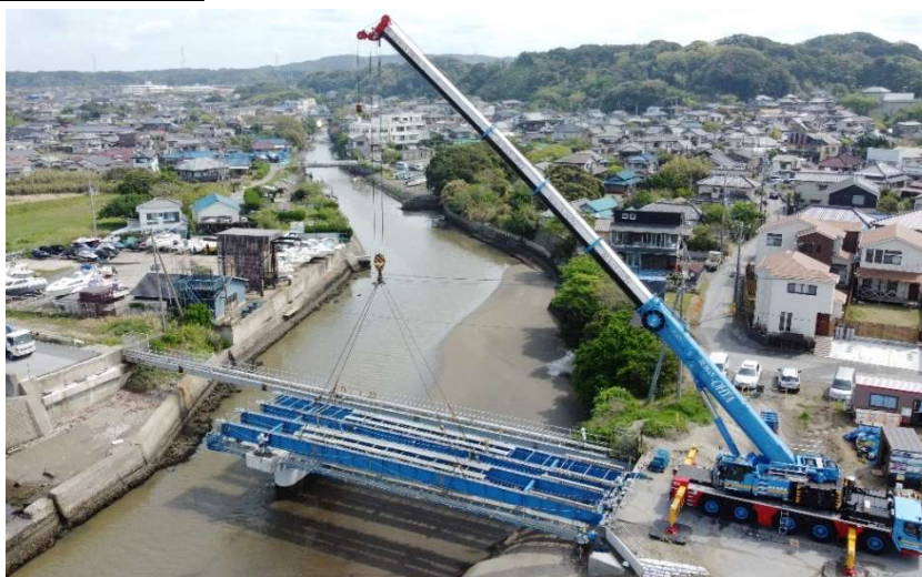
200 t 吊オールテレーンクレーンによる架設
