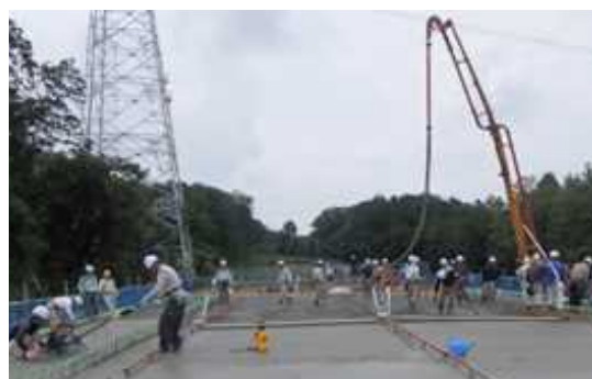
写真-4 実橋におけるレベラー施工状況
