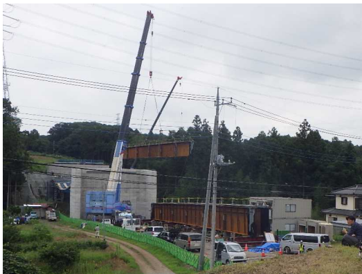
写真-1 架設状況
