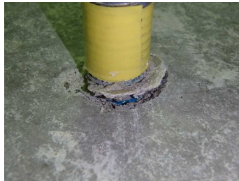
写真-6 引抜き試験後状況 (試験体 b-2)
