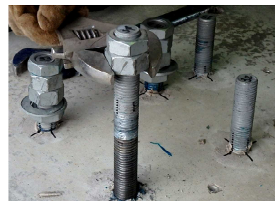
写真-1 Rアンカー抜取り状況
