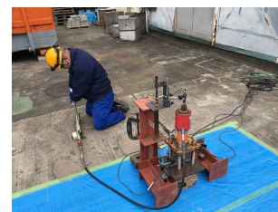
写真-3 引抜き試験状況
