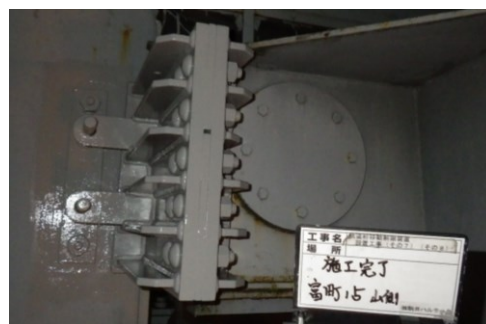
写真-5 移動制限装置施工完了
