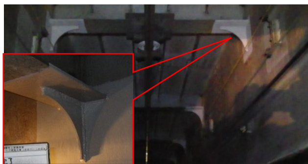
写真-4 隅角部補強施工完了 (R 付きリブ鋼板)
