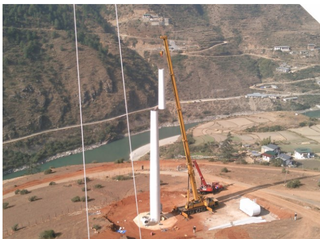
写真-4 タワー架設状況
