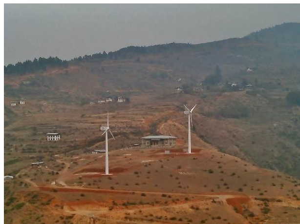
写真-5 完成したブータン風力発電所
