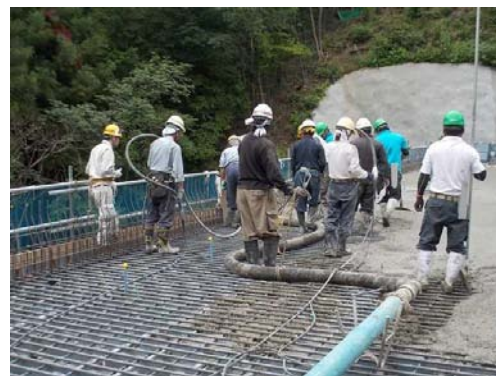
写真-6 コンクリート打込み状況
