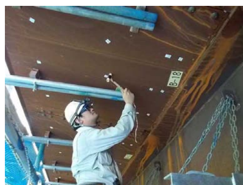
写真-5 検査状況(張出部)
