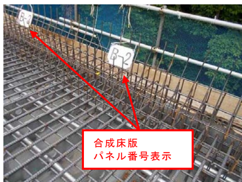
写真-2 検査状況(床版上面)
