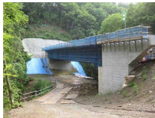
写真-7 6号橋全景
