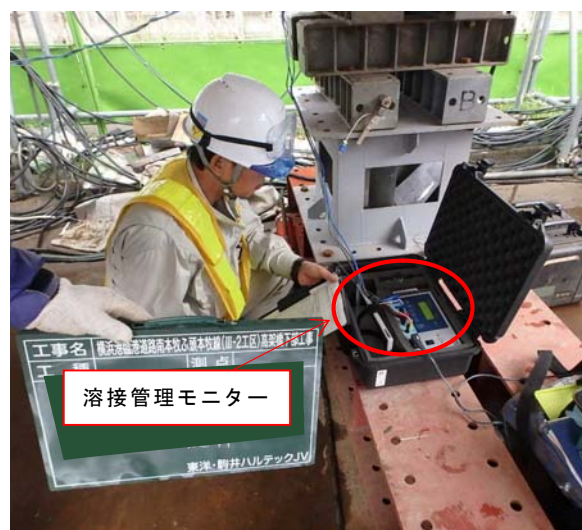
写真-10 溶接管理モニターによる入熱管理
