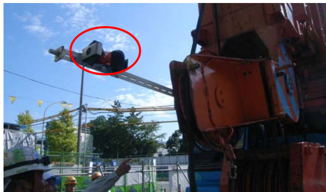
写真-4 360°プリズム設置（ブーム先端）
