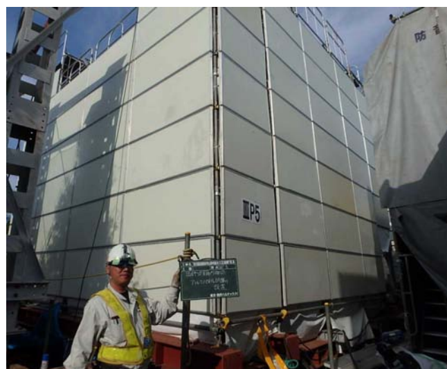
写真-11 ⅢP5 パネル防護足場
