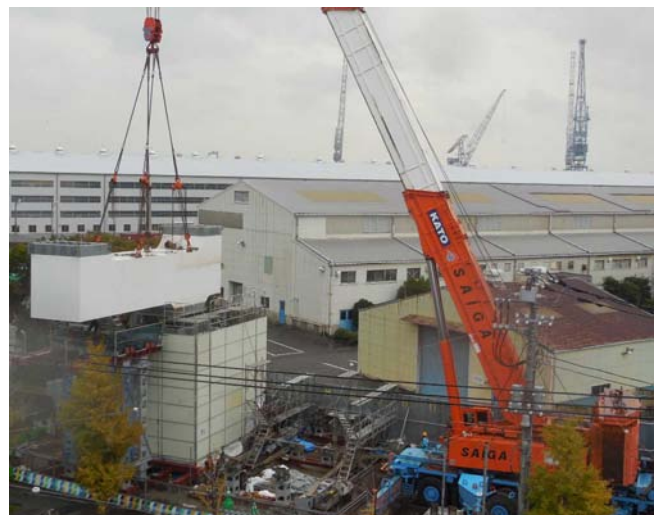
写真-8 ⅢP5 下層横梁架設状況
