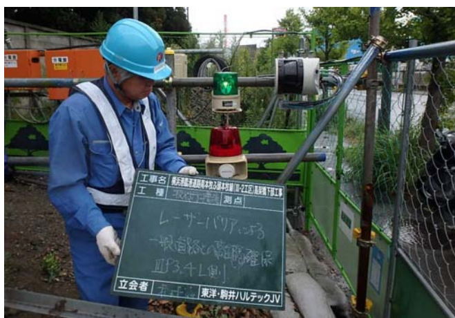
写真-3 レーザーバリア設置状況
