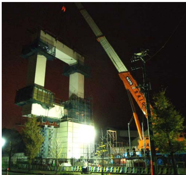
写真-9 ⅢP5 上層梁架設状況
