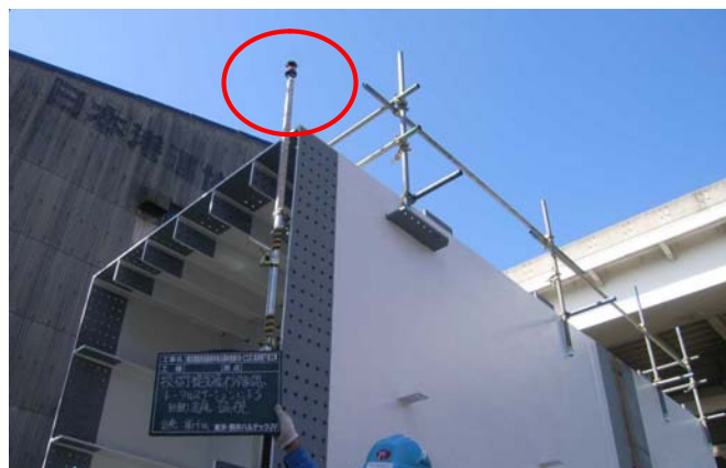
写真-5 360°プリズム設置（部材）
