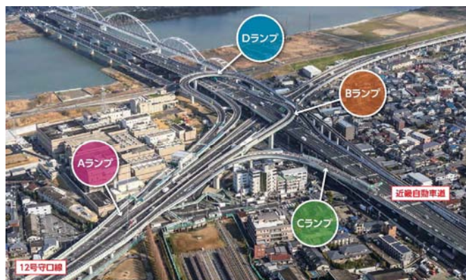
写真-5 守口ジャンクション全景
