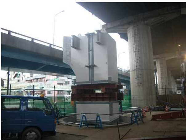
写真-1 基部・隅角部架設完了
