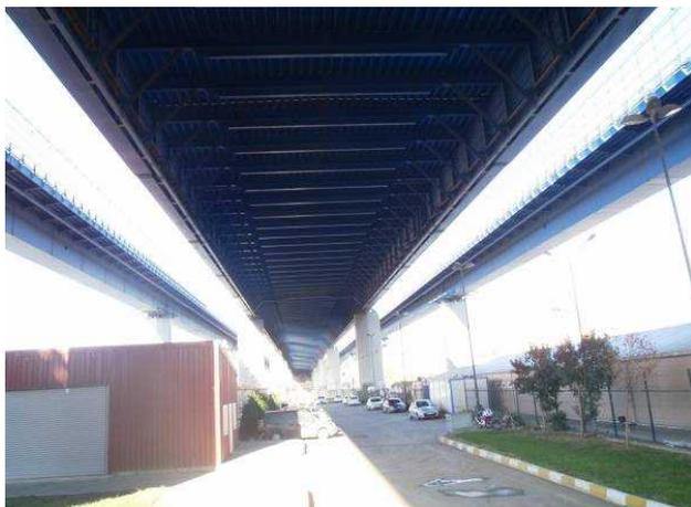
写真-6 ゴールデンホーン橋（中央部は主桁間隔 24m）
