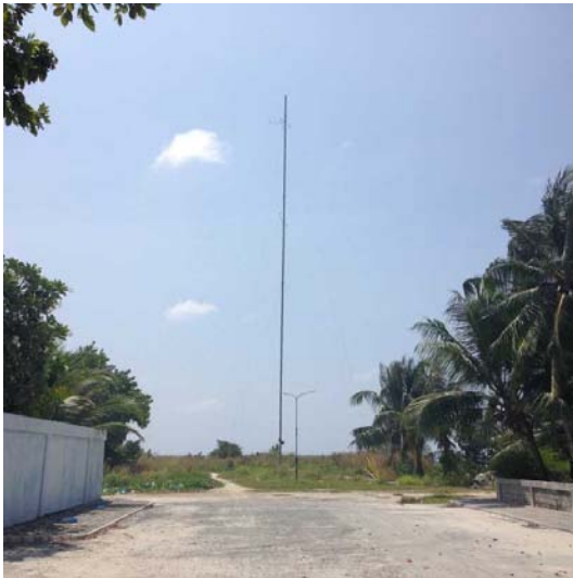
写真-1 クルドゥフシ風況マスト設置状況
