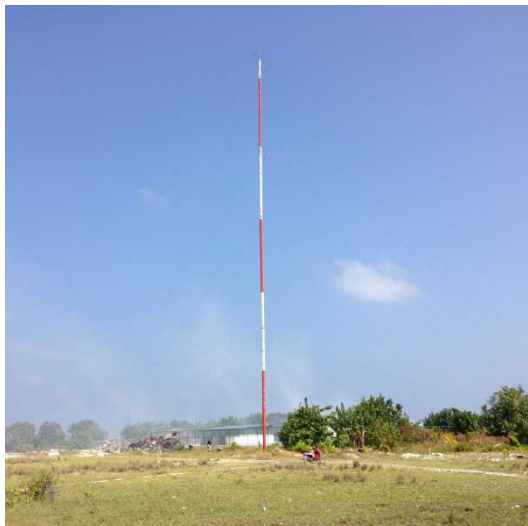
写真-2 ナイファル風況マスト設置状況
