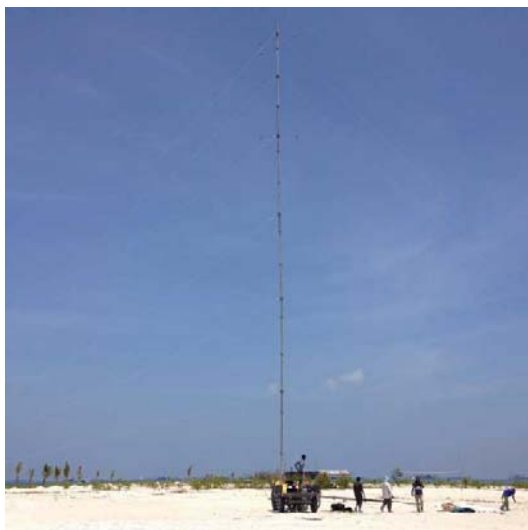
写真-3 グリファル風況マスト設置状況
