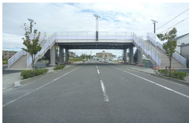
写真-3 照明設備
