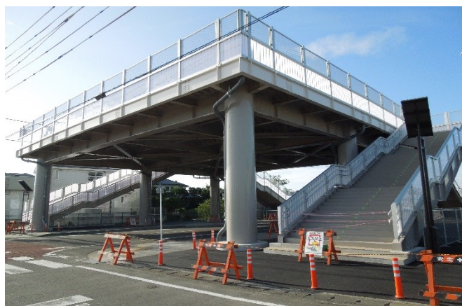
写真-1 津波避難タワー全景
