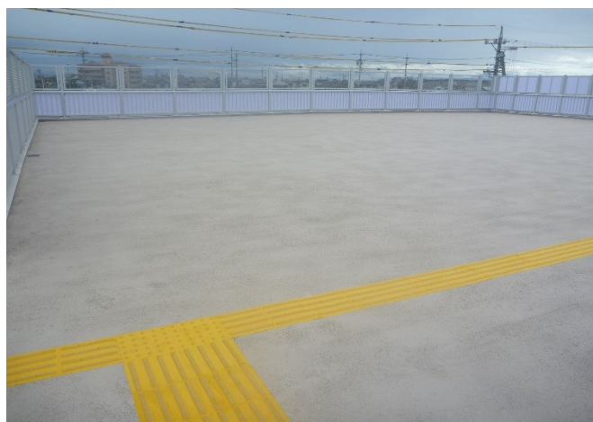
写真-2 橋面状況
