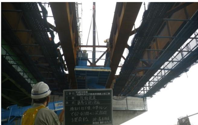
写真-4 G2, G3間の二次部材架設
