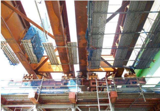
写真-2 桁架設完了
