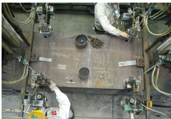
図-2 溶接施工状況
