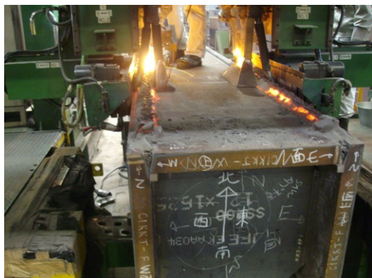
図-2 溶接施工状況
