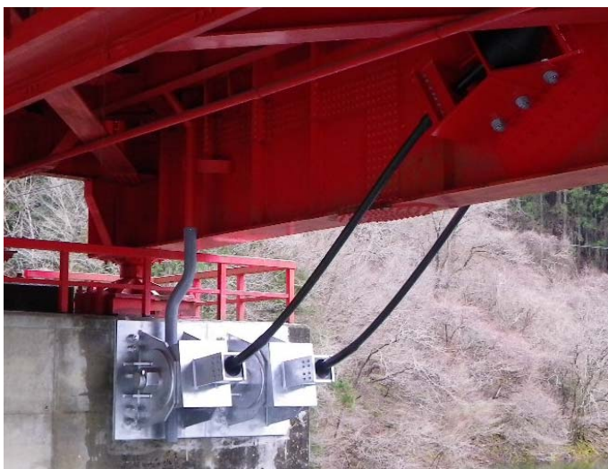
写真-1 落橋防止装置設置状況
