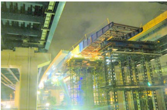
写真-3 送り出し状況
