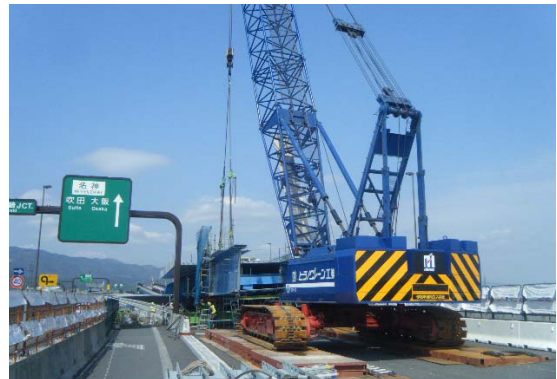
写真-4 桁架設状況
