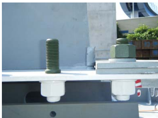
写真-5 節付き両ねじ高力ボルト
