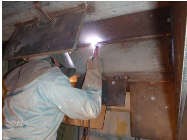
写真-2 現場溶接施工試験
