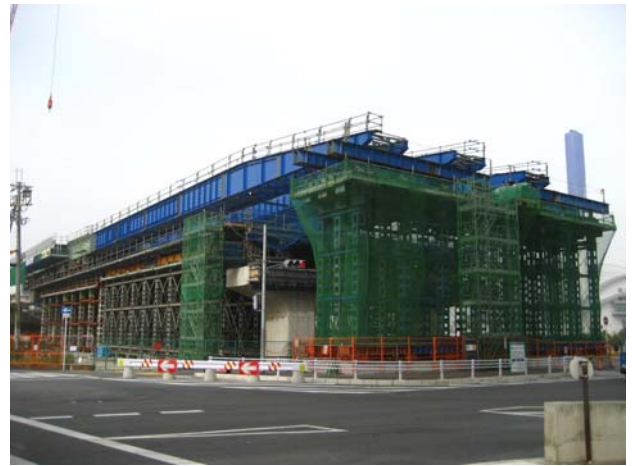
写真-2 送出し装置組立完了
