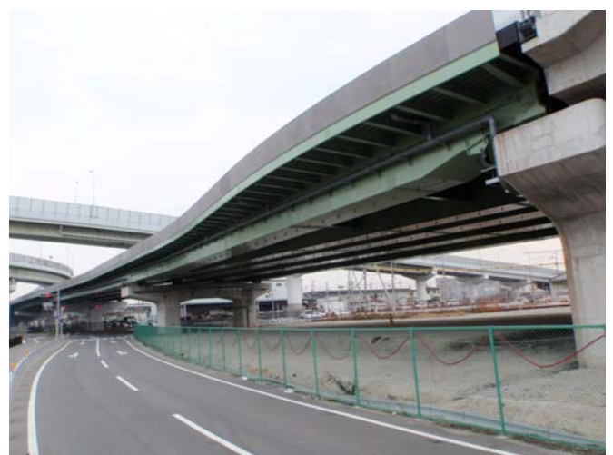
三宅高架橋 完成写真
