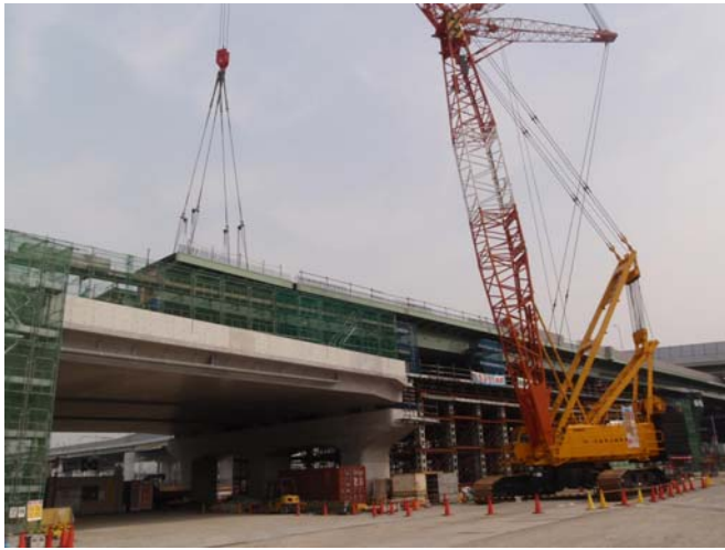
写真-1 300t吊クローラクレーンによる組立
