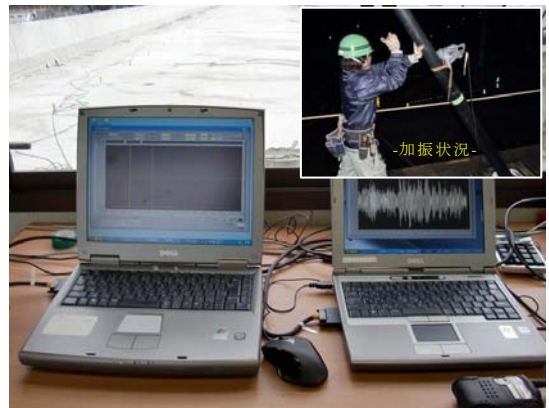
写真-1 振動法による張力算定状況
