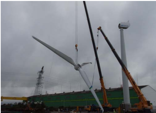
写真-8 対策ブレードの架設
