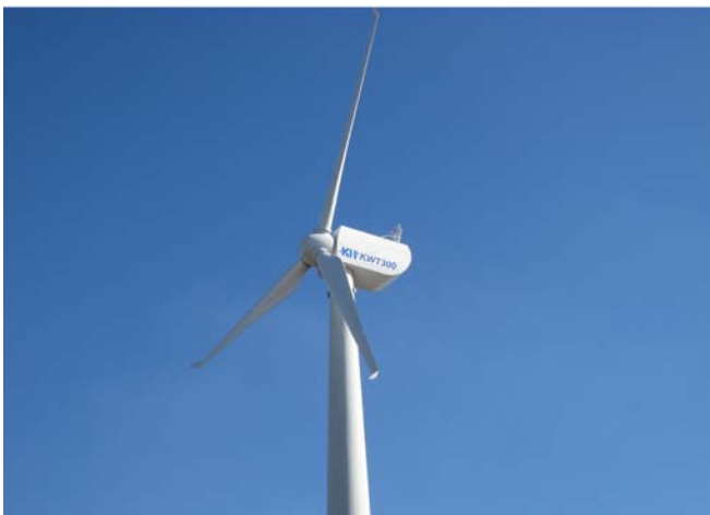
写真-9 架設完了
