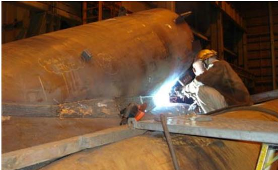
写真-4 分岐管の組み立て状況
