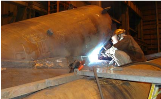
写真-4 分岐管の組み立て状況
