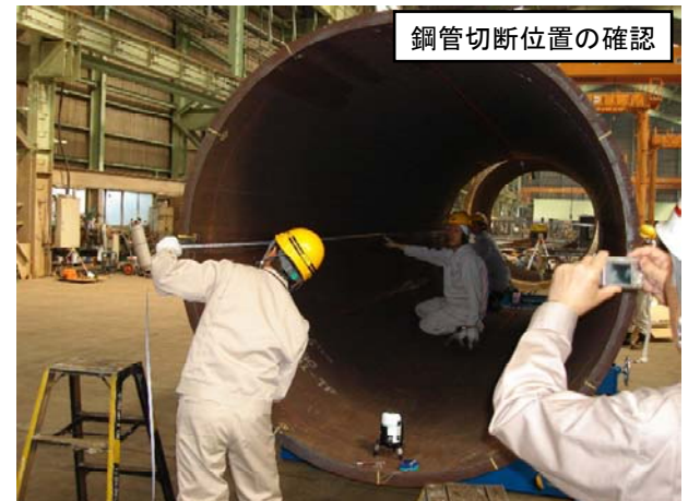
写真-2 1次罫書き 鋼管切断線の罫書き状況
