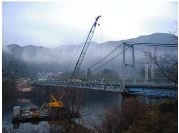
写真-3 床版ブロック撤去状況 (遠景)
