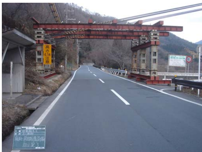
写真-4 府道上・道路防護設備
