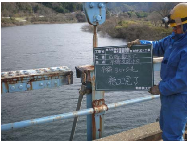
写真-1 橋体の3ヒンジ化
