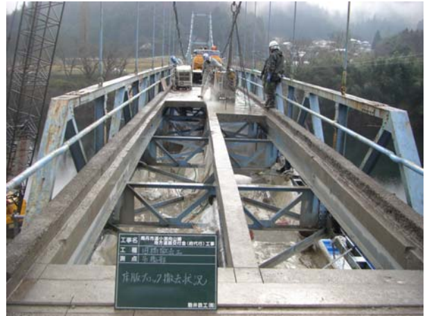
写真-2 床版ブロック撤去状況
