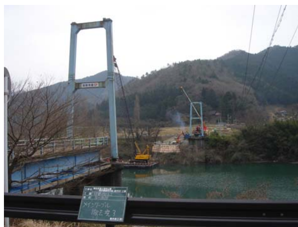
写真-5 メインケーブル撤去完了（右岸より）
