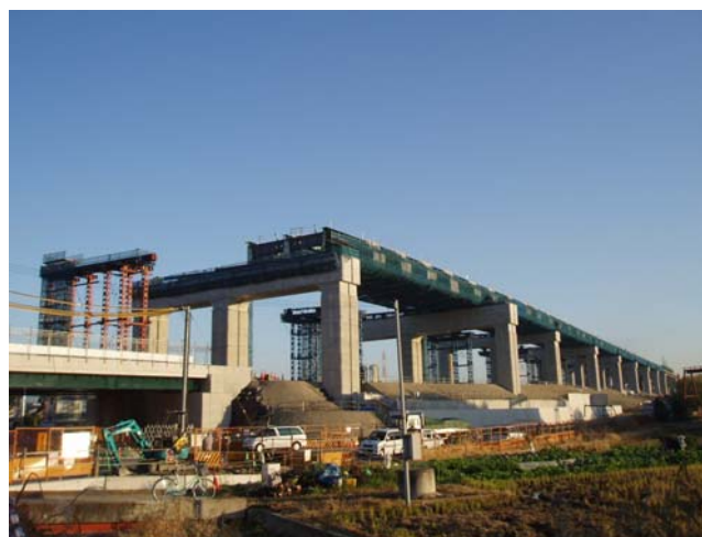
写真-3 架設写真(横取り後)
