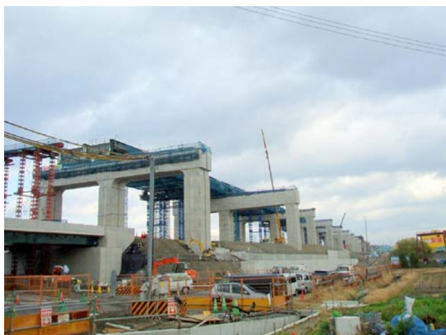
写真-2 架設写真(横取り前)
