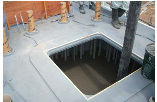
写真-4 高流動コンクリート充填状況
