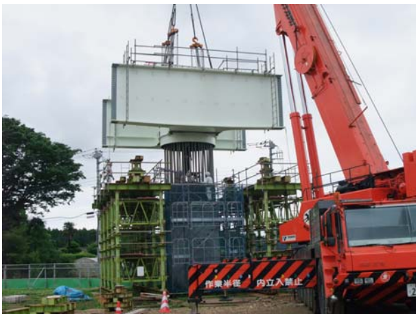
写真-3 落とし込み架設状況
