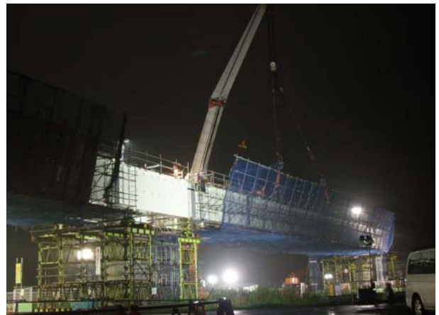
写真-5 夜間一括架設状況
