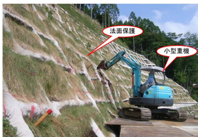
写真-2 法面保護撤去状況
