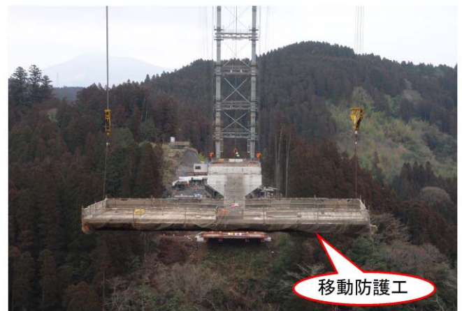
写真-5 移動防護工
