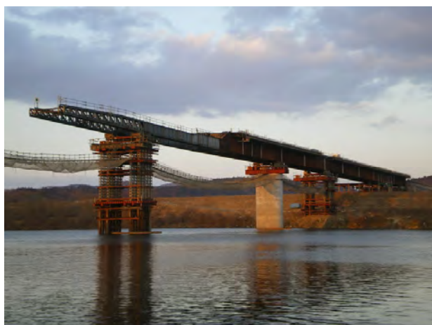
写真5 桁送出し状況
