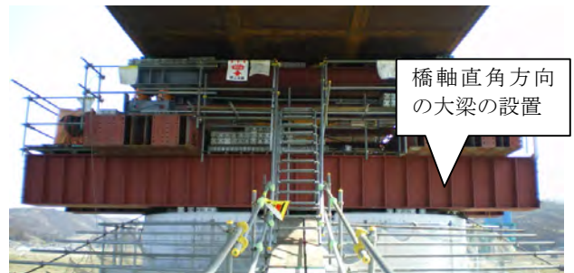
写真3 本工事での送出し設備
