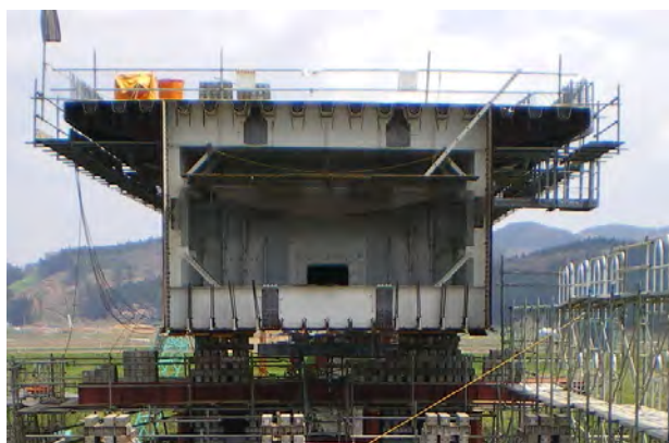
写真1 本工事の桁断面
