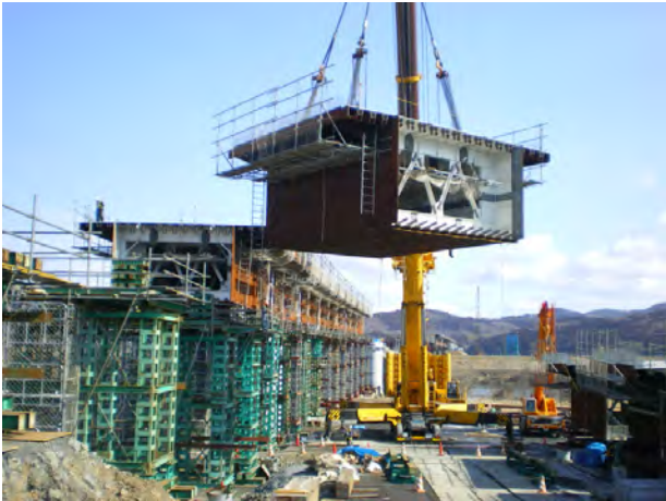
写真7 地組桁の架設状況
