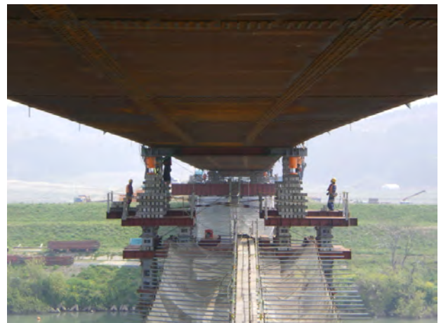
写真8 桁降状況
