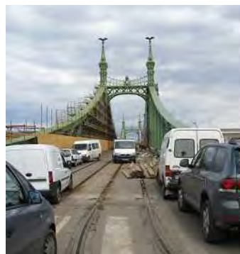
写真- 22 通行止めの様子
