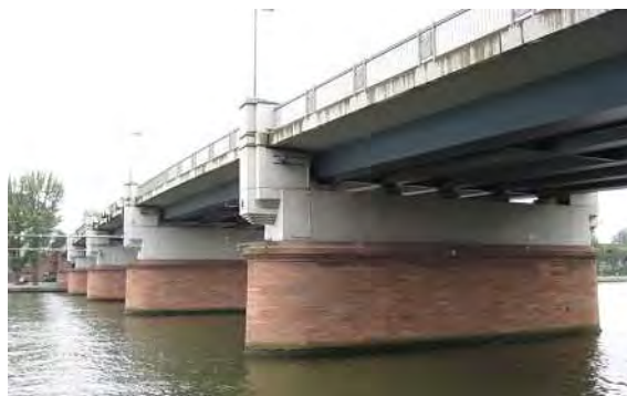
写真- 12 ウンターマイン橋
