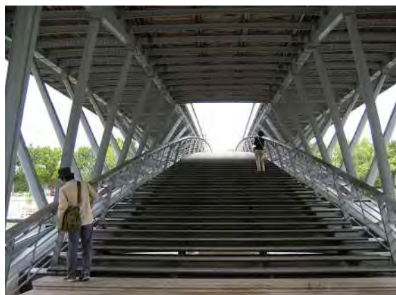
写真- 6 アーチリブ内の空間
