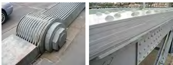
写真- 19 チェーンと補剛桁のフランジ
