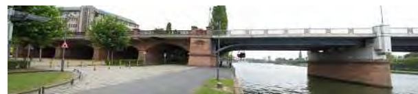
写真- 13 桁端のアーチ部
