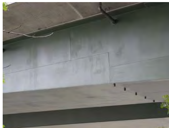
写真- 17 リフトアップ部の継手
