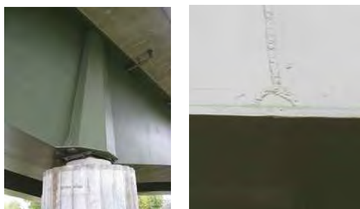
写真- 16 中間支点部と現場溶接の スカーラップの処理
