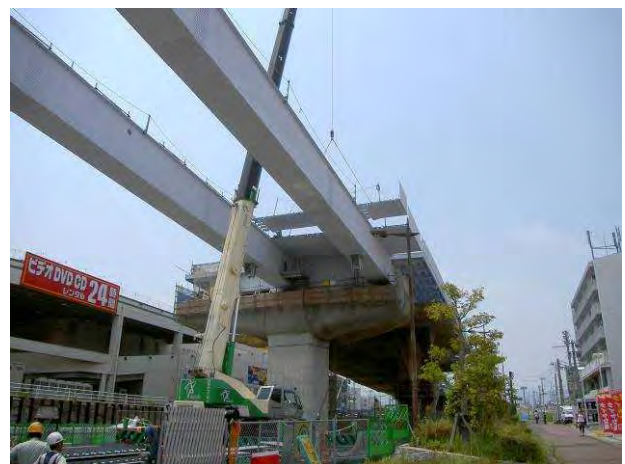
写真-2 パイプスラブの架設状況
