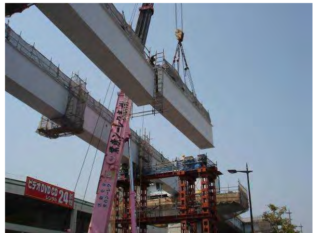
写真-1 細幅箱桁の架設状況
