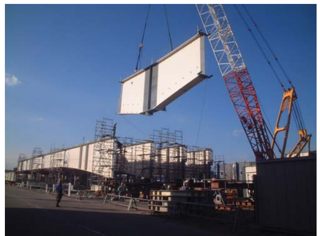
写真-2 地組立状況
