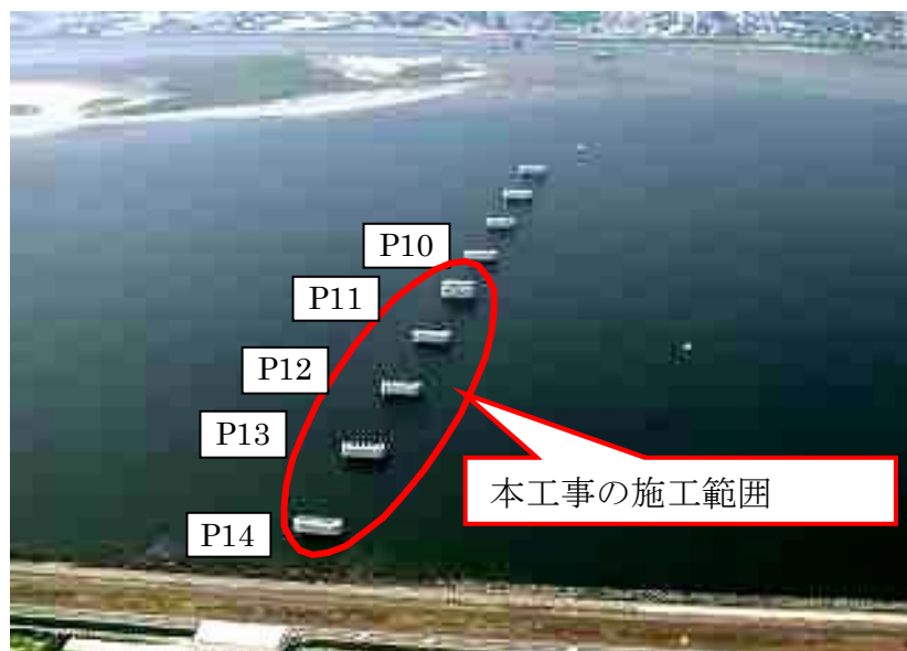
写真-1 架設前状況
