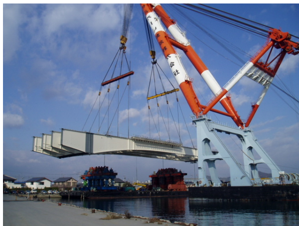
写真-4 FCによる積み込み状況
