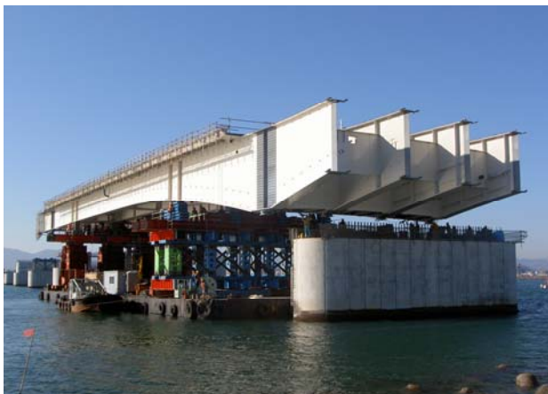
写真-6 台船引込み状況
