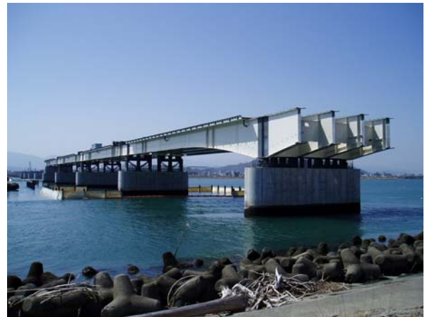
写真-7 架設完了全景
