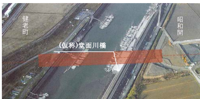
写真-1 架設位置
