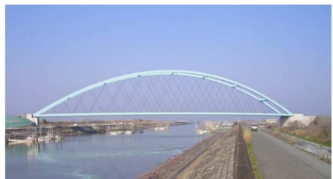
写真-6 全景（平成18年3月）
