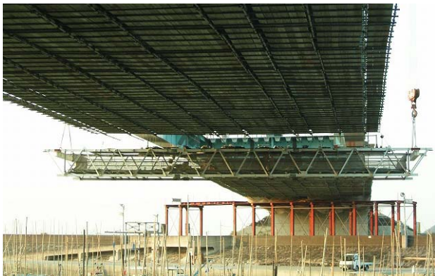
写真-2 移動防護工
