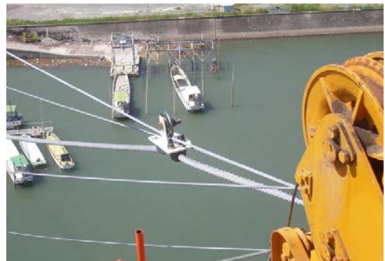
写真-3 トラックケーブル展張状況
