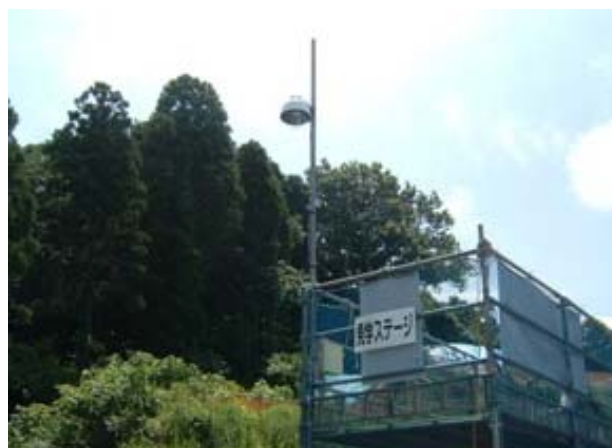
写真-1 ライブカメラ設置状況
