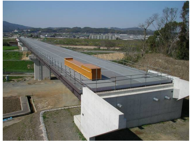
写真-5 完成写真
