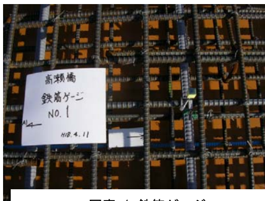
写真-1 鉄筋ゲージ
