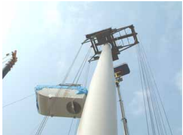
写真-1 ナセルの架設状況(1)
