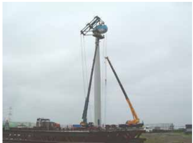
写真-2 ナセルの架設状況(2)
