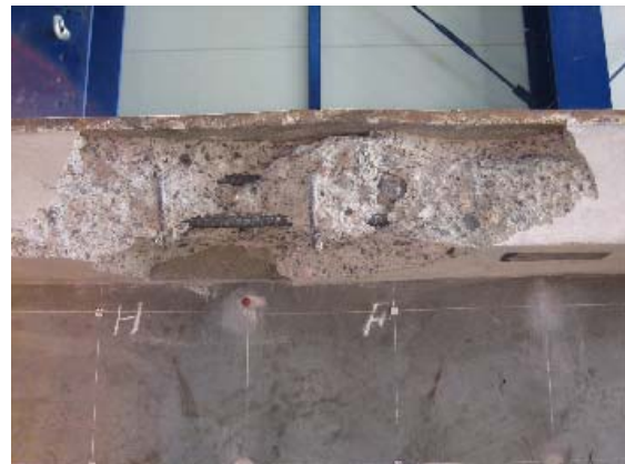
写真-1 試験体圧壊状況
