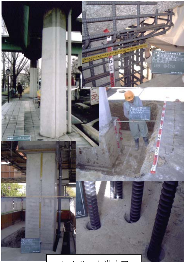
コンクリート巻立工
